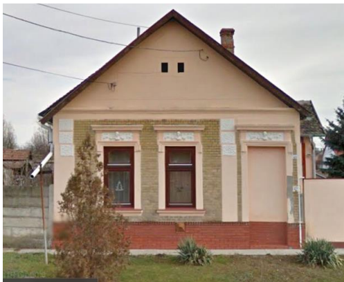
Zrínyi sugárút 43. (Lakóház Petőfit ábrázoló homlokzattá dísszel 49) hrsz 2003 azonosító 15446
